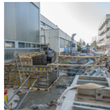
8 Zahlreiche Bauprojekte am Institut
